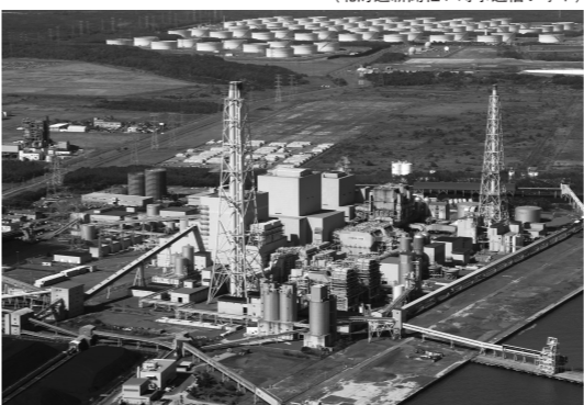
●10月10日に全面復旧した苦東厚真発電所
