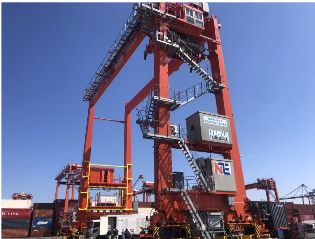
<神戸国際コンテナターミナルのタイヤ式門型クレーン>
